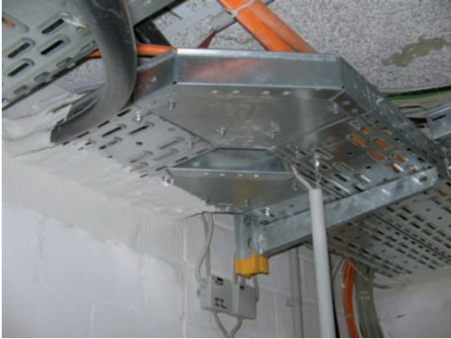
Abb. 4.39: Mineralfaserplattenschott mit durchlaufender Leitungstragekonstruktion und gemäß An- bzw. Verwendbarkeitsnachweis einseitig zu weit entfernt installierter Abhängung
