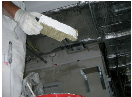
Abb. 4.45: Mineralfaserplatten mit seitlicher Beschichtung
