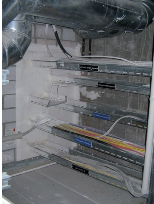
Abb. 4.39: Mineralfaserplattenschott mit durchlaufender Leitungstragekonstruktion und gemäß An- bzw. Verwendbarkeitsnachweis einseitig zu weit entfernt installierter Abhängung
