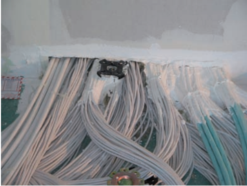
Abb. 4.42: Nicht fertiggestelltes bzw. erweitertes Schott, das bereits während der Errichtung überbelegt ist
